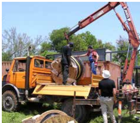
Déchargement du container avec l'Unimog
