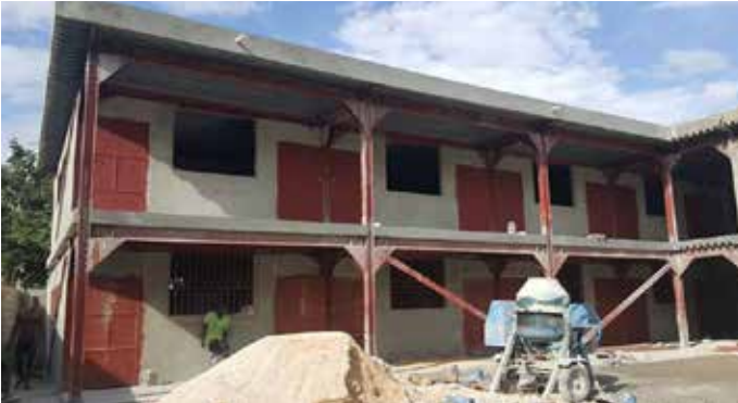
Das Gebäude steht bereits
