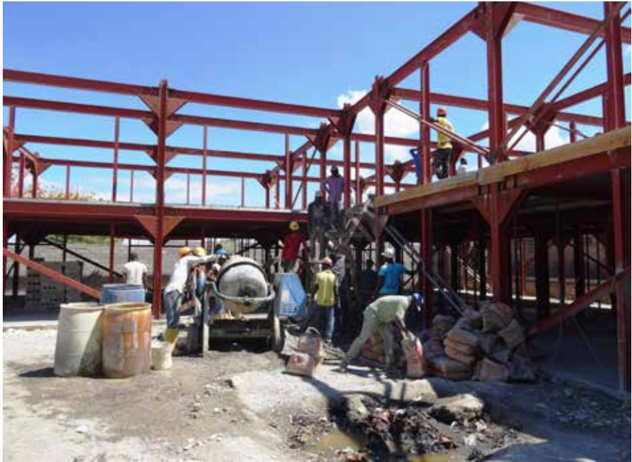
La construction métallique solide
