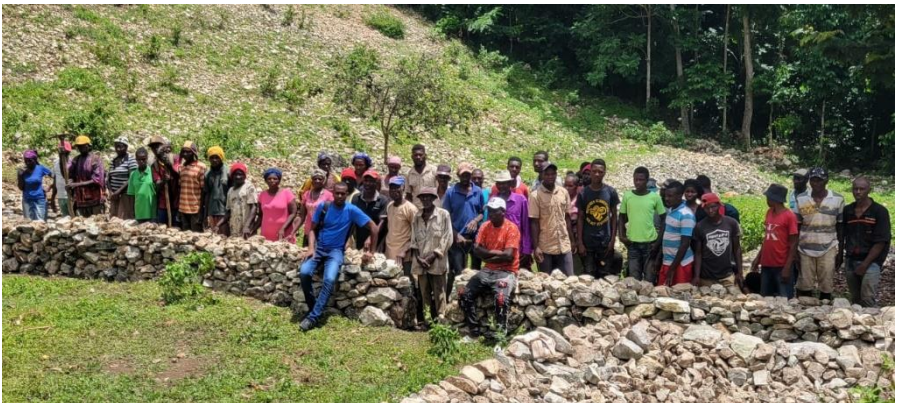
Errichtung von Steinmauern
