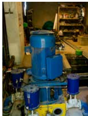
La turbine est réparée.
